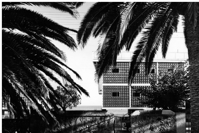
Casa al Mare a Santa Marinella Studio Lafuente, Santa Marinella 1951 - 1960
